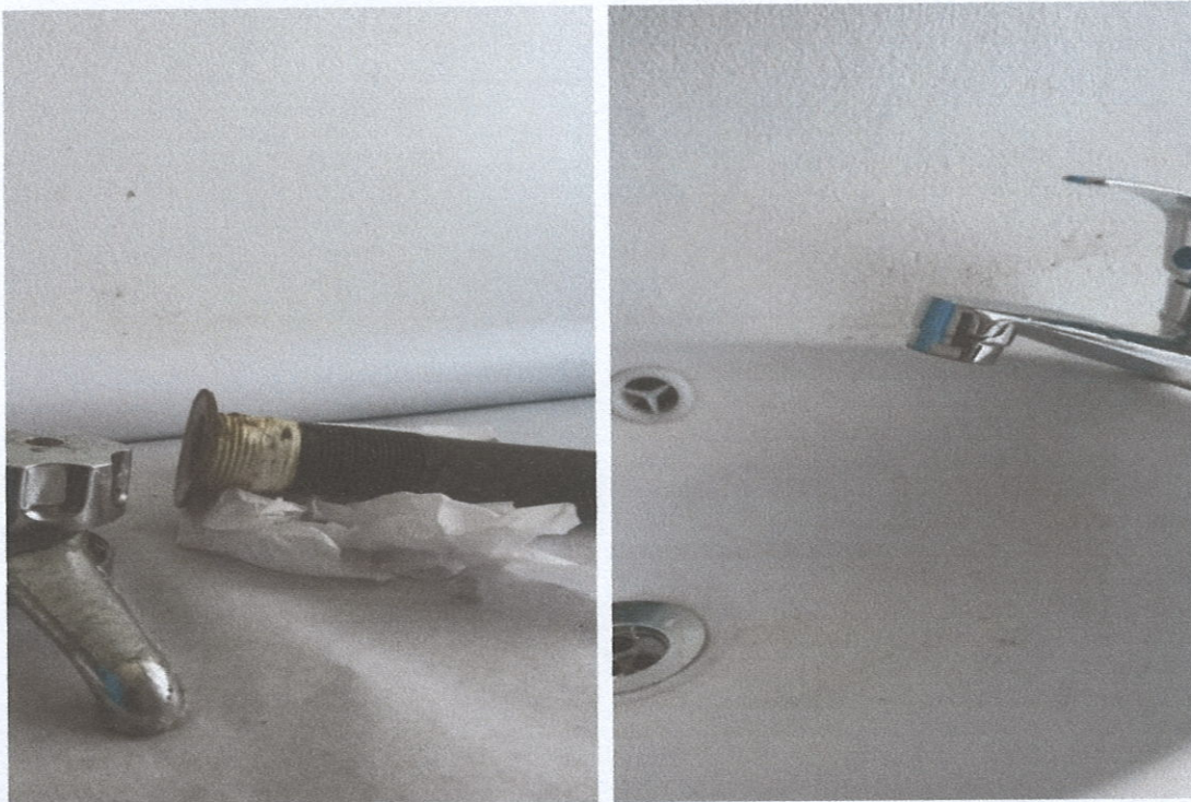
Sustitución llave de lavamanos dañada, además de la boquilla, en consultorio exterior # 3.
