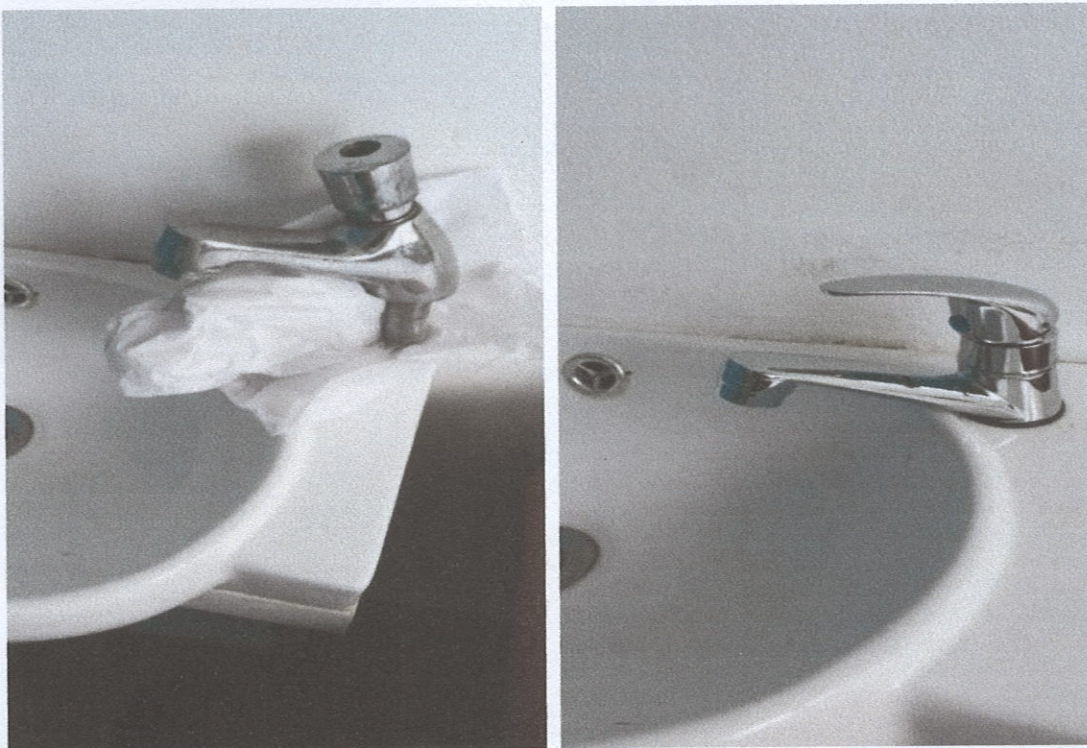
Sustitución llave de lavamanos dañada, en consultorio externo #4.
